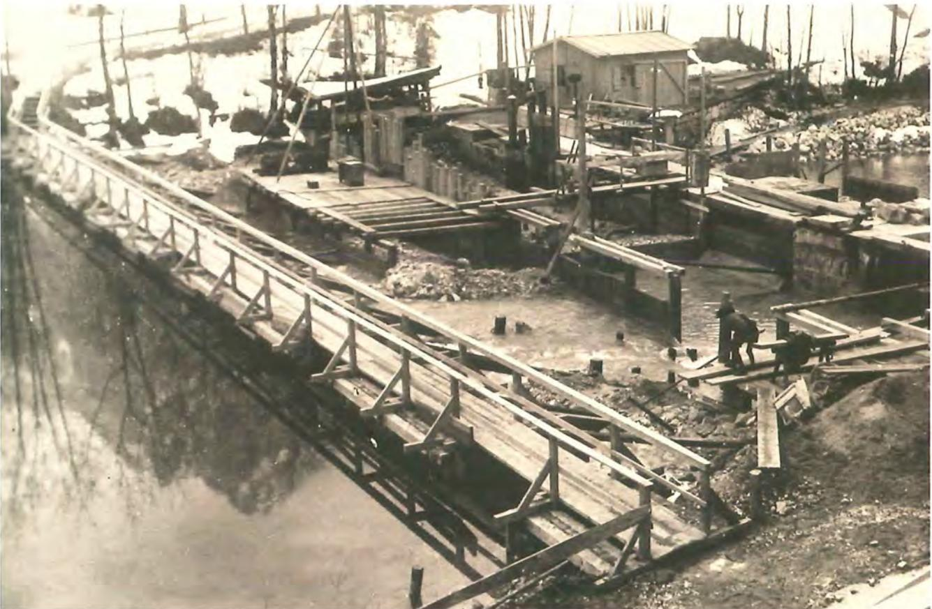
Ein Blick auf die Baustelle „Seeklause“ im Winter 1938/39. Unter dem Fußgängersteg befindet sich der Absperrdamm, der den Wasserspiegel des Königssees während der Bauzeit gehalten hat. Rechts im Bild sieht man die Steinpfeiler, von denen einige unterspült waren und neu fundiert werden mußten. – Die Bauhütte durfte bei der kalten Winterarbeit und der langen Bauzeit nicht fehlen.
