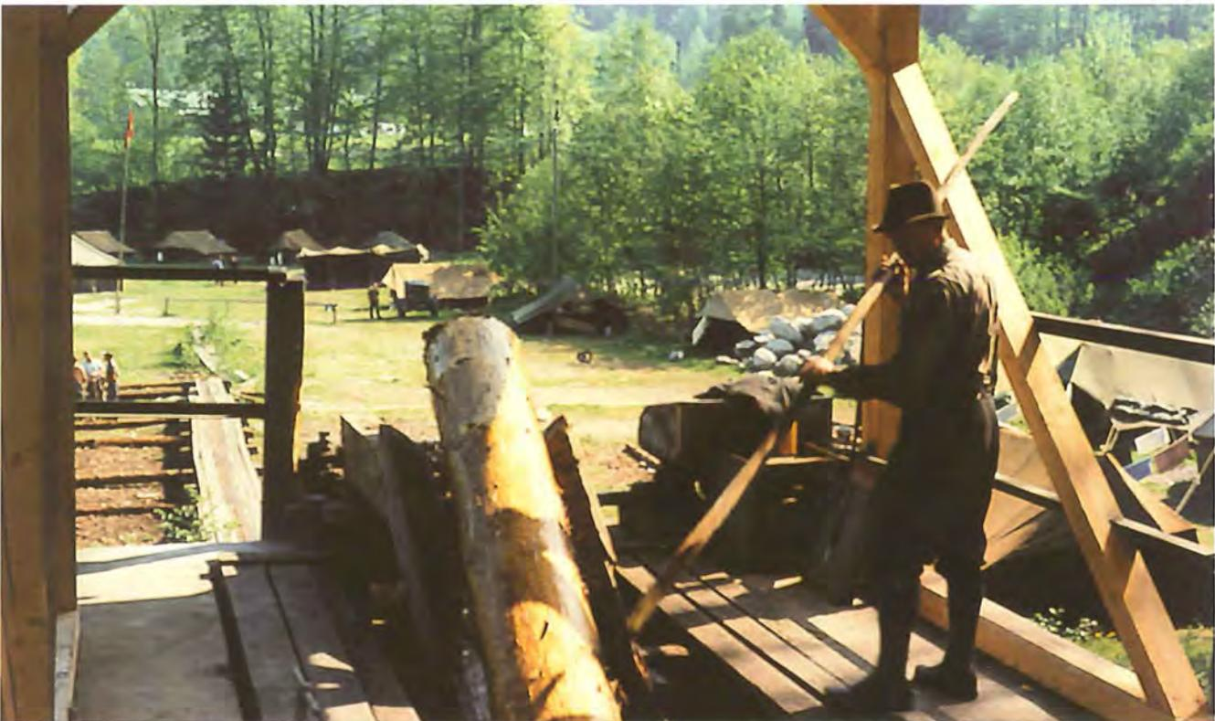
An der Ausländeanlage, die sich am Ende des Bremsbeckens befindet, schiebt ein Waldarbeiter mit seinem Rohn einen Stamm auf die Förderkette. Schon haben ihn die Eisenspitzen der Kette erfaßt und heben ihn aus dem Wasser. Bei genügender Höhe kippt der Stamm über und gleitet die Rutsche hinunter. – Der Waldarbeiter ist Haumeister Franz Wahlich von Schönau. Übrigens, die Zelte die auf dem Bilde zu sehen sind, gehören einer englischen Militäreinheit, die hier eine Übung abhielt.
